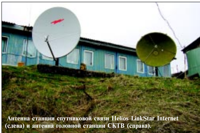
Антенны с рефлектором от станции «Москва» на о. Кунашир.
